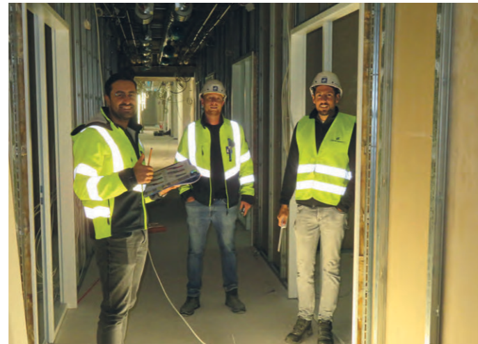
■ Teamarbeit: Bauleiter Yunus Özüdoğru mit Christian Merz, Assistent der Bauleitung, und Werkstudent Hakan Korkmaz (v.l.n.r.) auf der Baustelle am Niehler Hafen.
