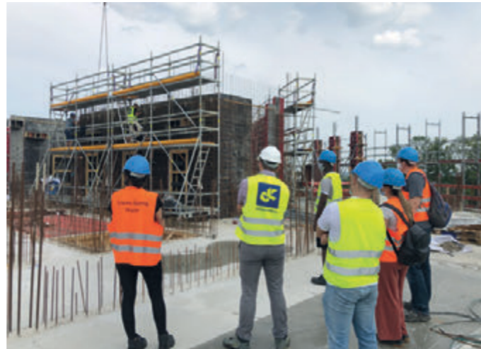
■ Projektleiter Adam Czaplá mit den Studenten der FH Aachen auf der Baustelle FMAC am Campus Melaten, Aachen
